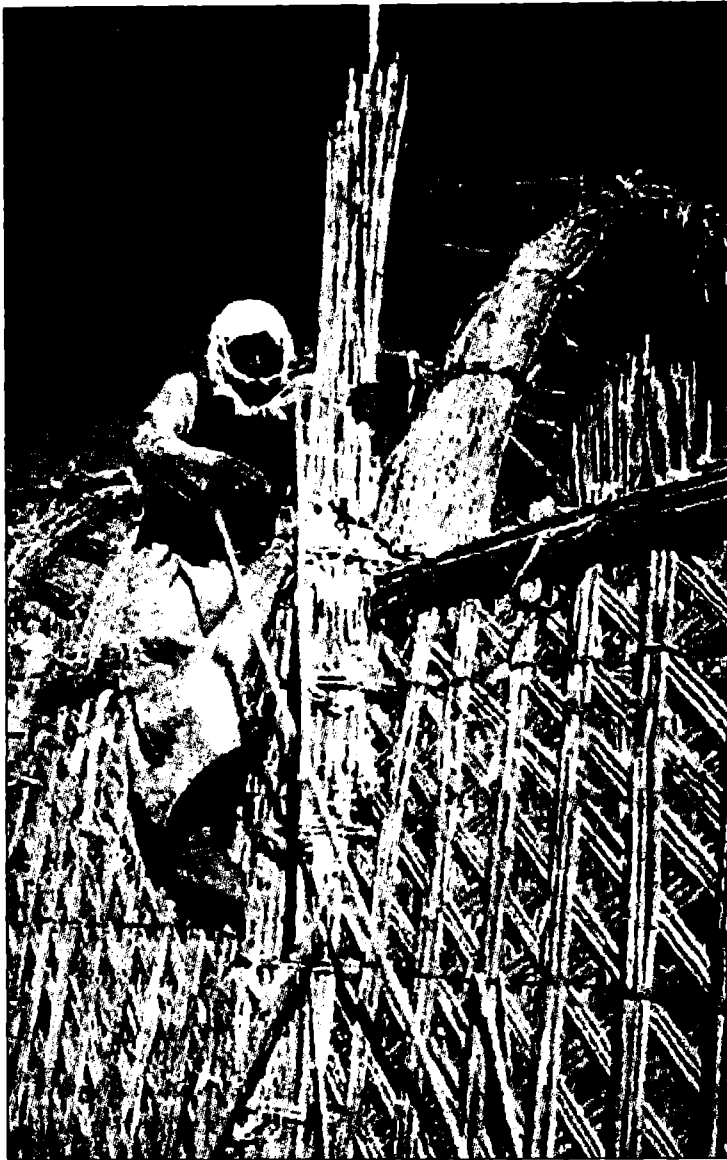
بيت القصب أثناء عملية البناء ويبدو زخرفة القصب التي تعرف بـ(بالمشبك)
