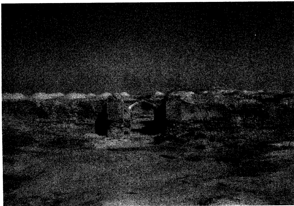
تصویر شماره ۱۷- نمای کلی دیگری از کاروانسرا از طرف جنوب.
